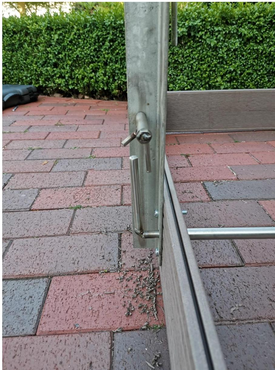
Die Sicherung ( das Blech) einkürzen, so dass es auf dem oberen Deckel endet und diesen blockiert
